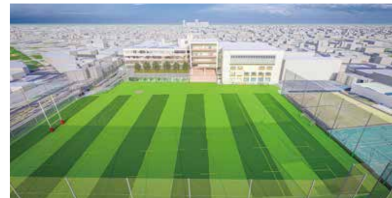
城北の広大なグラウンド。2022年9月には、全面人工芝化の工事が完了する予定です
