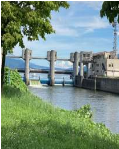
【写真：釜口水門】
