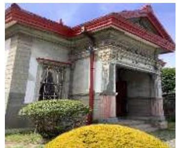
【写真：旧林家住宅玄関ポーチ】
