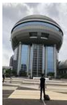
【写真：有明水再生センター外観】
