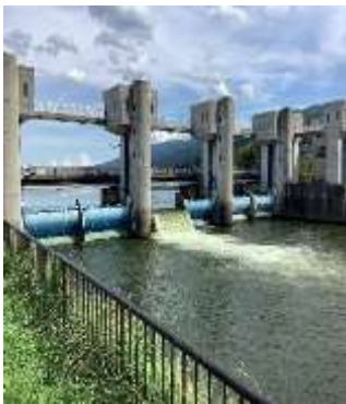
【写真：釜口水門】
