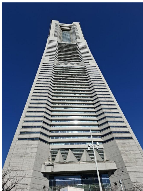
【写真：横浜ランドマークタワー外観】
